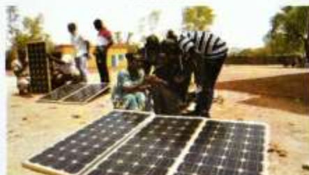
Formation/installation de syst. solaires PV
