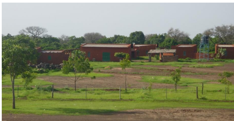
Ferme pilote de Filly.
